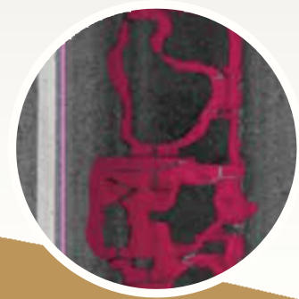
密封補修されている ひび割れ
